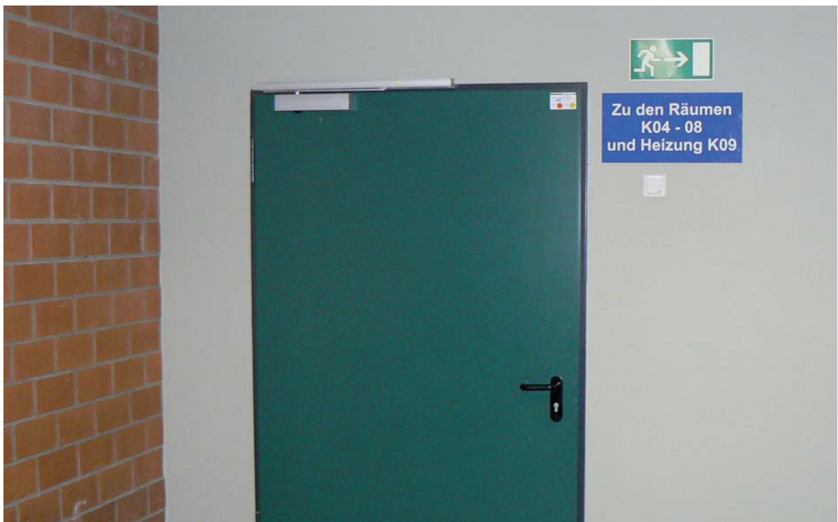
Foto: Zu den Räumen Keller 04-08 (Klassenräume) und Heizung
