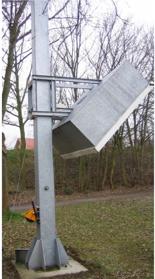
Geschossfangkasten mit Fallbremse und Führung am Mast.
